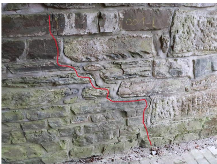
Foto č. 2 Opěra O 01 – vlevo – schodovitá trhlina
