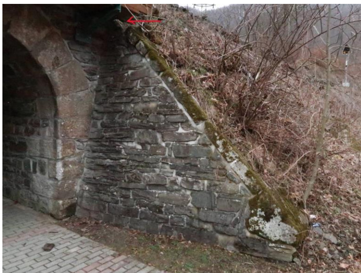
Foto č. 3 Opěra O 02 – křídlo vpravo – odpadnutý kámen římky křídla
