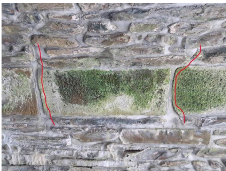
Foto č. 1 Konstrukce K 01 – líc vpravo vrchol – trhlina
